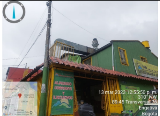
Fotografía No 4. Ducto y punto de descarga del horno tipo trompo y la parrilla que operan con leña como combustible
