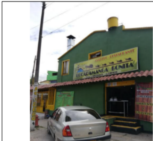
Fotografía No. 1: Fachada del predio.
